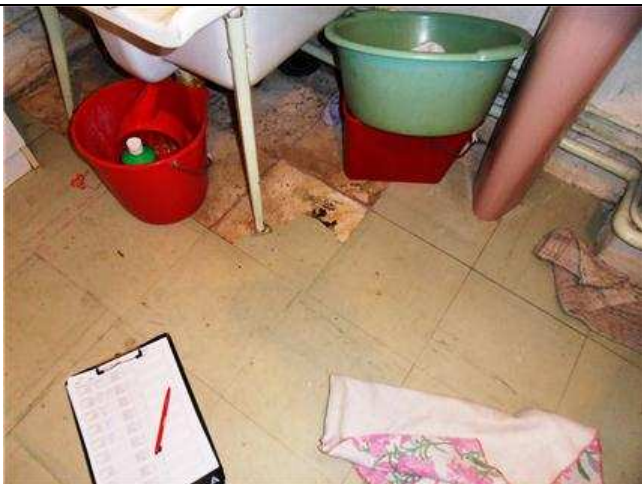
006 - Appartements - Salle d'eau LOT 0002 PH27 : Colle noire et ragréage PRE:008
